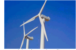
Aria ed energia pulita "Fattoria Eolica Pian dei Corsi"
